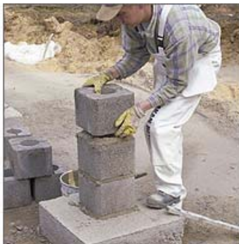
KUVIO 12. Pilariperustuksen valmistusta pilariharkoilla ja valetulla anturalla toteutettuna (Harkkoyhteisö n.d.)
